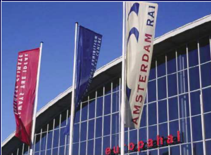
Centro de Convenciones y Exhibiciones Ámsterdam RAI, Sede del evento.
